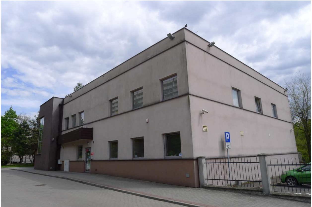
Widok ogólny budynku
